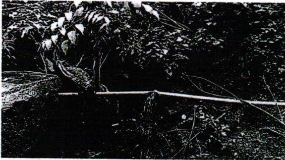
Tubería de Fo.Go., a la salida de la caja dos, a la que se le debió conectar tubería de 2", para alimentar la caja general.
